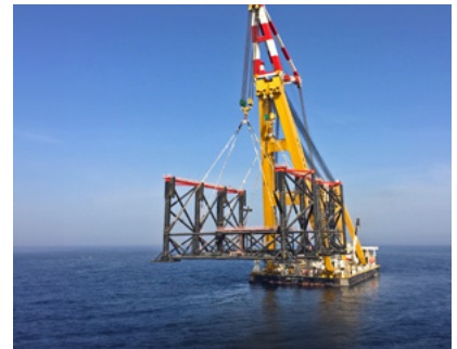
4 FLOATING SHEERLEG CRANES
